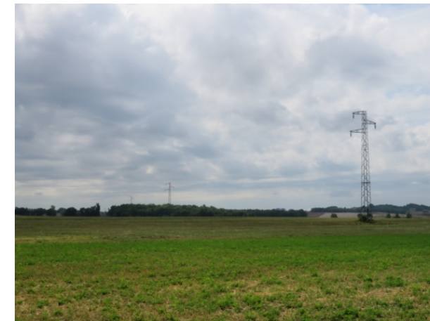
Ligne électrique THT traversant la zone est d'étude
