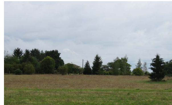
Lignes électriques HTA et BT au nord de la zone est d'étude, au niveau du lieu-dit « Les Grèzes »
