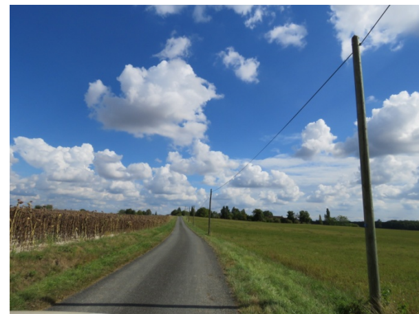
Ligne de télécommunication longeant la route des Grèzes entre les lieux-dits « Courrouge » et « Les Grèzes »
