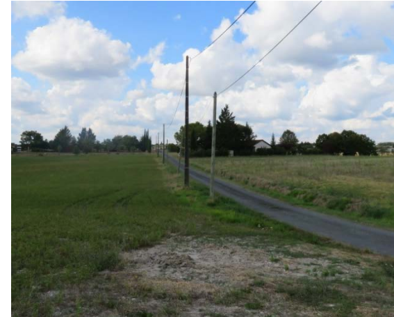
Ligne BT longeant l'est de la zone est d'étude
