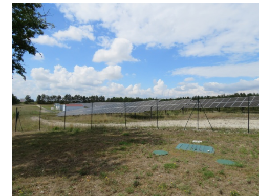
Nord-ouest du parc photovoltaïque
