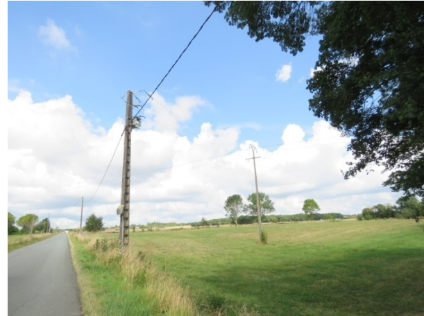
Ligne BT à l'ouest de la zone est d'étude longeant la RD 22
