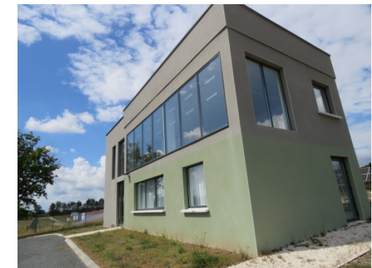
Local pédagogique du parc photovoltaïque
